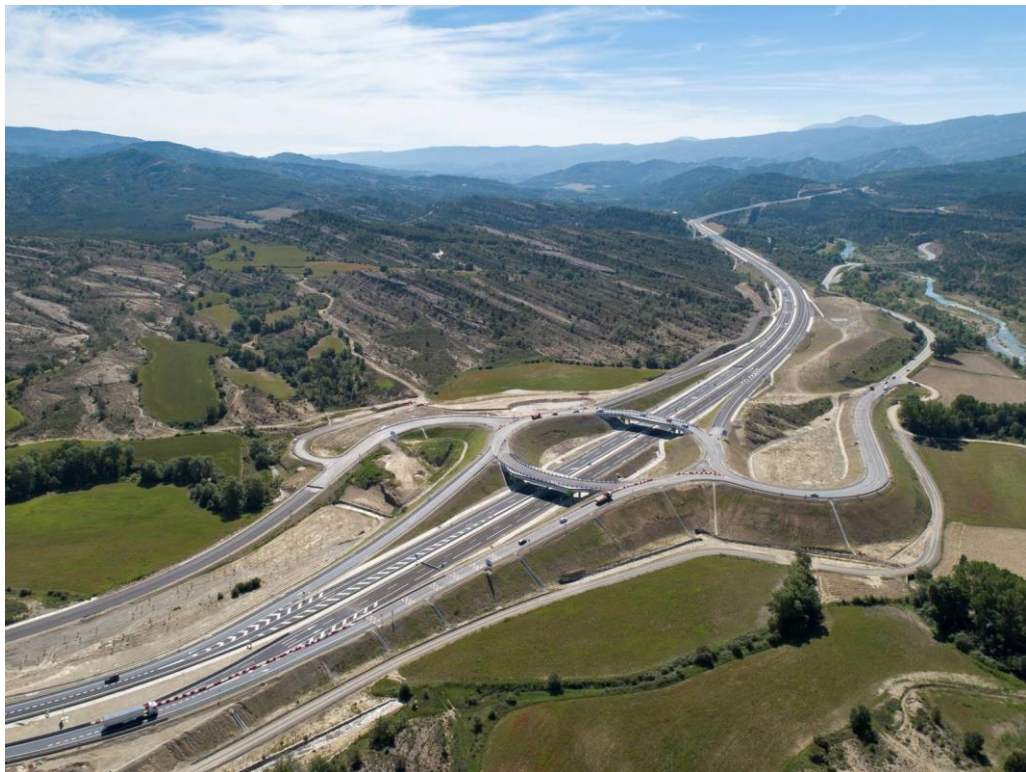
Enlace de Lanave
